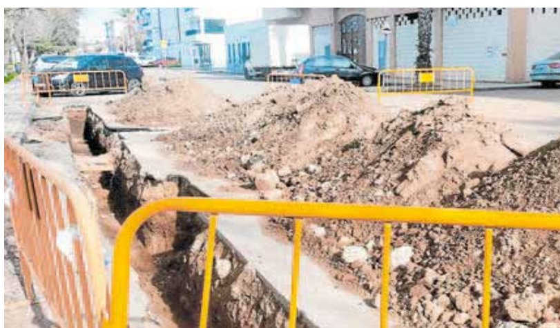
Zanja abierta en María Auxiliadora por la obra de sustitución de tuberías. J. M. ROMERO
