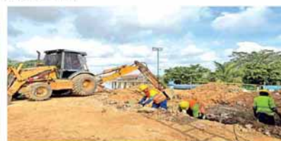
Así fue el inicio del cambio de la tubería en la zona de captación en el Río Sinú.
