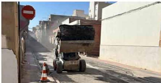
Asfaltado de calles en Albal tras la dana. / A.A.
