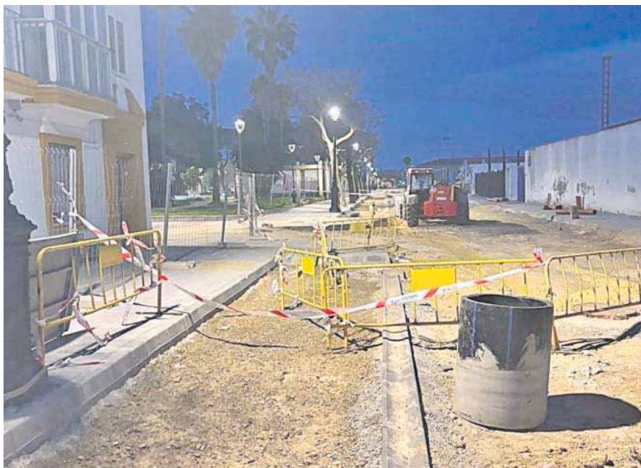
Una imagen reciente de las obras en la avenida de la Bajamar.
