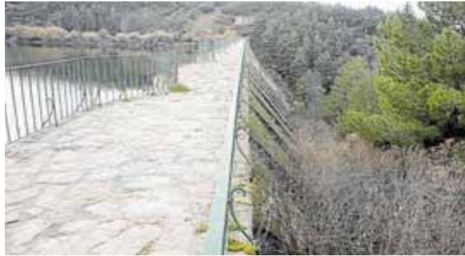
Pasarela peatonal en la presa de Puente Alta. A. DE TORRE
