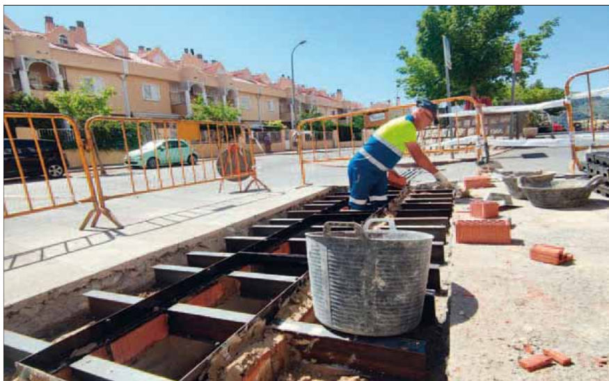
ARCHIVO. Un operario de Aqualia arregla un imbornal en la confluencia de la Carretera de Jabalcuz y la calle La Gloria.
