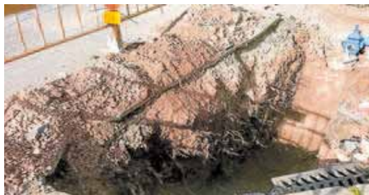
Tramo de red nueva que se está colocando. J. M. ROMERO
